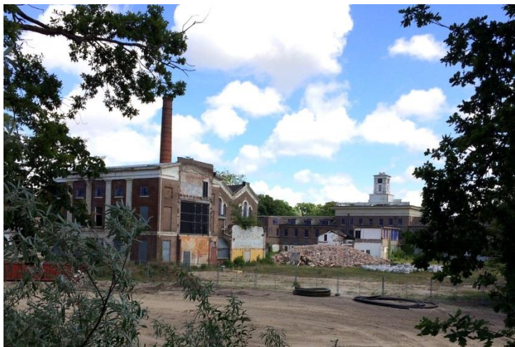
De sloop in 2017 van het oudste gebouw van het vroegere krankzinnigengesticht Meerenberg, later het Provinciaal Ziekenhuis Santpoort.
